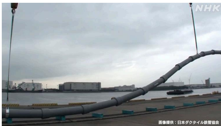
耐震化された水道管
